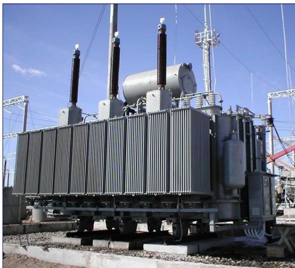
**Рисунок 7 – Шунтирующий реактор**
